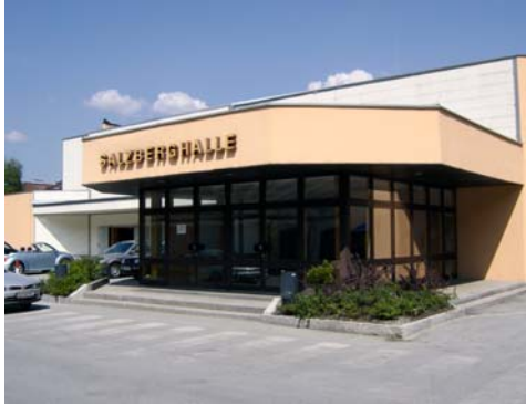
Tagungshalle in Hallein (Foto: M. SCHWEIGER)
